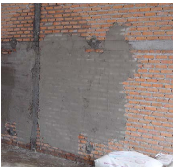
รูปที่ 4.6 พื้นที่ในการทำงานฉาบปูนผนังภายในอาคารของโครงการ B
