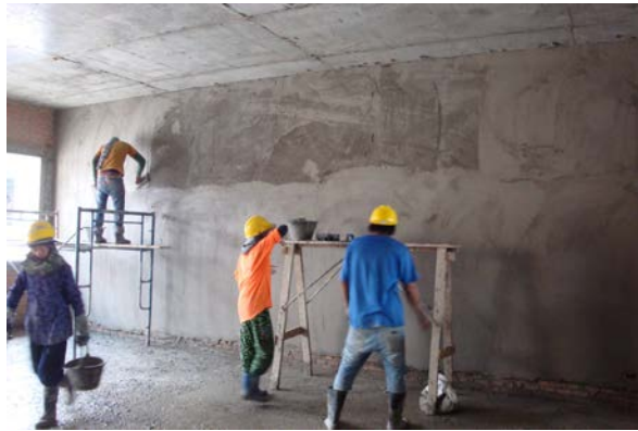
รูปที่ 4.3 พื้นที่ในการทำงานฉาบปูนผนังภายในอาคารของโครงการ A
