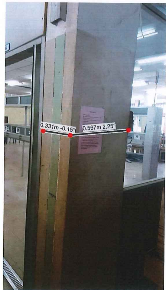
ภาพที่ 4.14. การสำรวจพื้นที่ภายในอาคารเดิมที่จะทำการปรับปรุง โดยมีการใช้เครื่องวัดระยะแบบดิจิตอล
