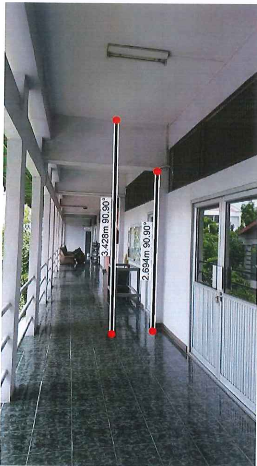
ภาพที่ 4.14. การสำรวจพื้นที่ภายในอาคารเดิมที่จะทำการปรับปรุง โดยมีการใช้เครื่องวัดระยะแบบดิจิตอล
